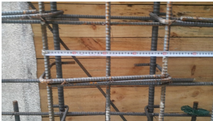
a) rebar spacing
